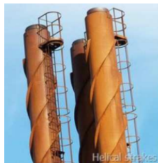
Figure 6 – Exemple de VIV sur un riser et dispositif anti-VIV sur des cheminées.
